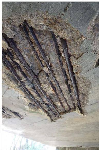
Detail pohledu NK u opěry OP2, odpadávající vrstvy betonu až na nosnou výztuž, která koroduje.
