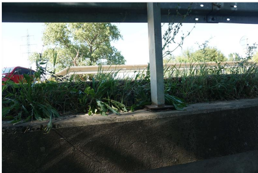
Boční pohled na převrstvenou vozovku a vyrůstající vegetaci.
