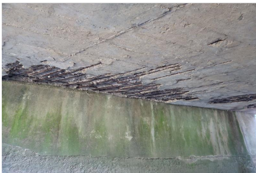
Detail pohledu NK u opěry OP1, odpadávající vrstvy betonu až na nosnou výztuž, která koroduje.
