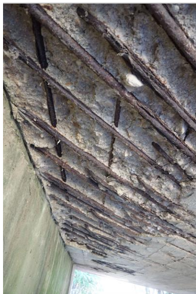
Detail pohledu NK u opěry OP1, odpadávající vrstvy betonu až na nosnou výztuž, která koroduje.
